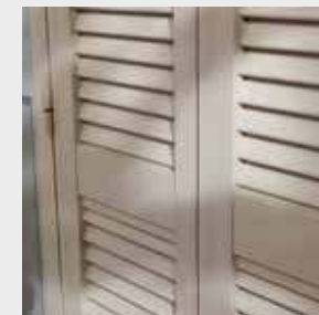
Particolare ovalina stecca fissa con tranciato in tinta Detail of oval fixed slat
